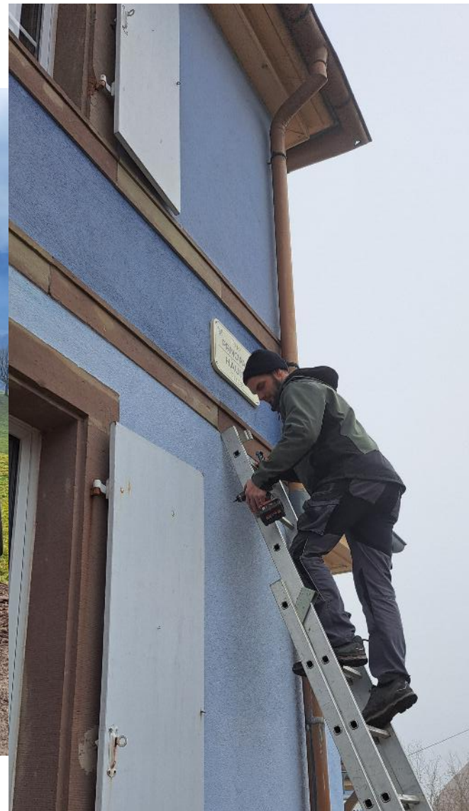
Chantier en cours sur la commune pour les plaques des rues.
